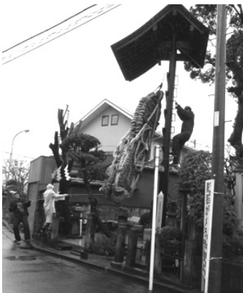
4月8日旧わらじの取り外し作業
